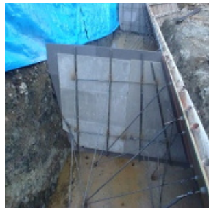
アングルを設置した 側面の状況
