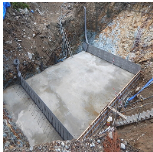
2か所設に設置されたSF工法 (遠景)
