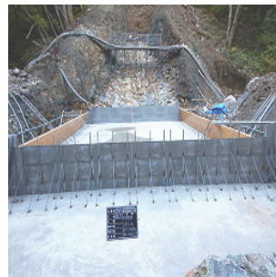
2か所設に設置されたSF工法 (近景)
