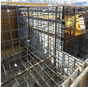
鉄筋構造物の擁壁
