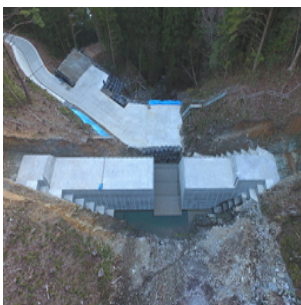
施工途中の砂防堰堤 (2)
