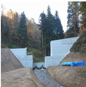
施工途中の砂防堰堤 (1)
