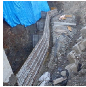
複数スパンの目地材が 設置された状況
