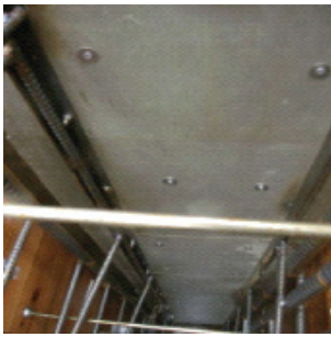
アングルを設置した 側面の状況
