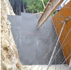
目地材を設置する 側面の状況
