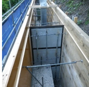
アングルを設置した 側面の状況
