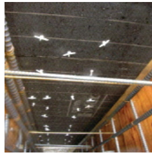
目地材を固定した 側面の状況
