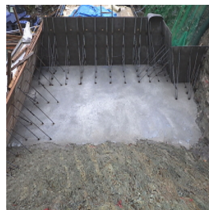
斜め上から見た状態
