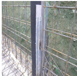
アングルを設置した 側面の状況
