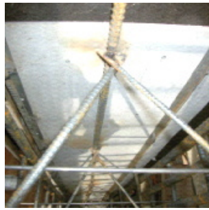
アングルを設置した 側面の状況2
