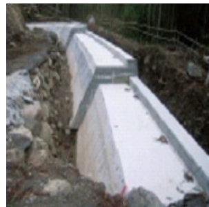
基礎が完成した状況
