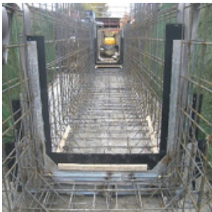
スレートボードを 設置した状況
