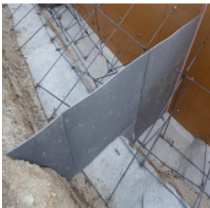
目地材を設置する 側面の状況
