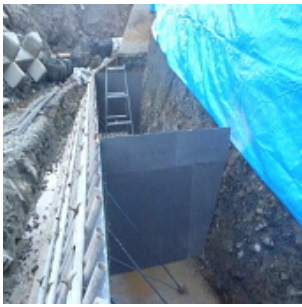
目地材を設置する 側面の状況
