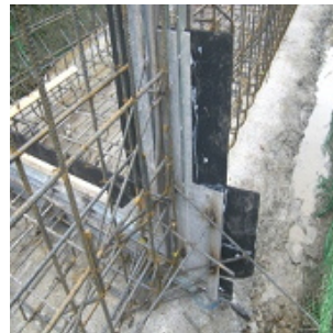
アングルを設置した 側面の状況-2
