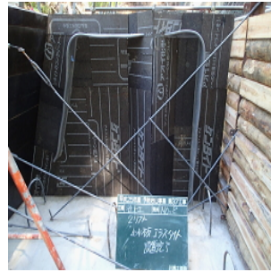
目地材を設置した
