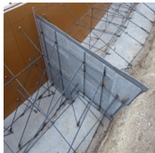
アングルを設置した 側面の状況
