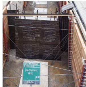
目地材を設置した後の側面
