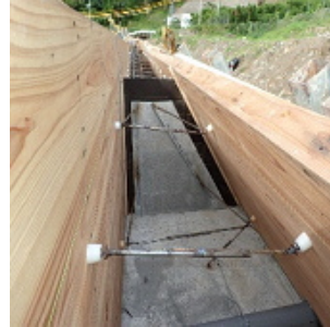
アングルを設置した 側面の状況-2
