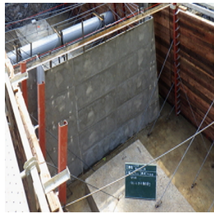
目地材を設置する側に側面
