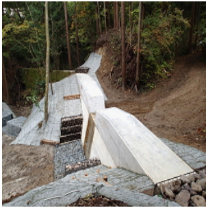
完成した谷止工
