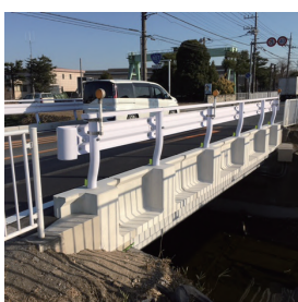
橋梁改修(張出し)
