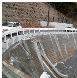
既設ブロック
