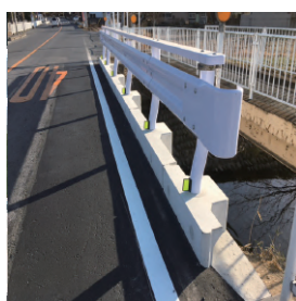
橋梁改修(張出し)
