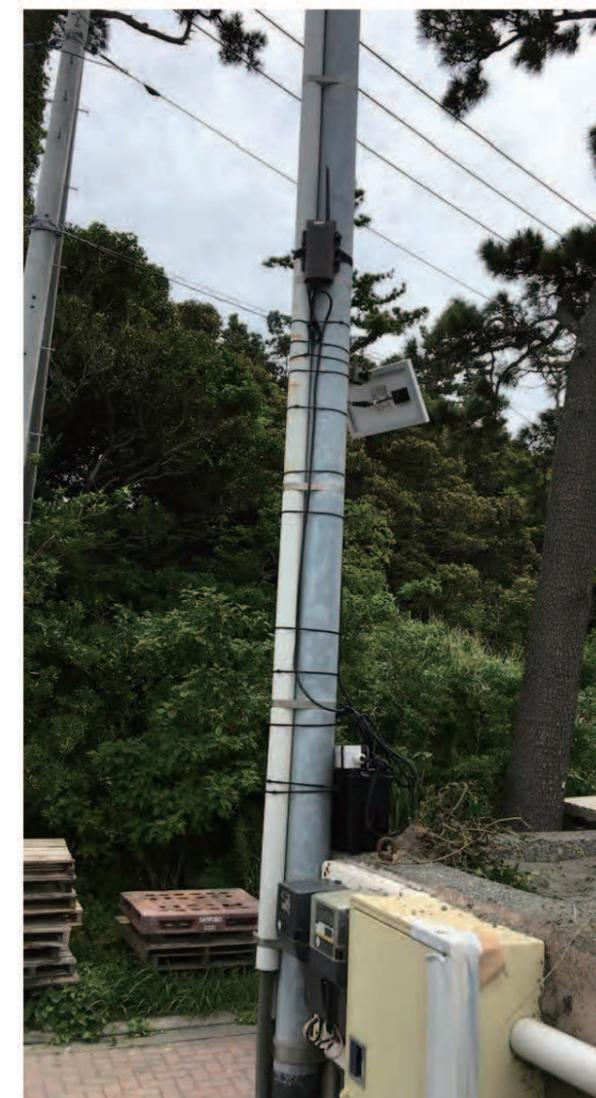
▲中継機+外部バッテリー+ソーラーパネル+5M延長ポール
