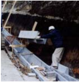
吊り込み状況
