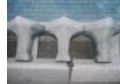
積みブロック設置状況 背面
