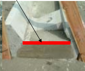
コンクリート打設面位置
