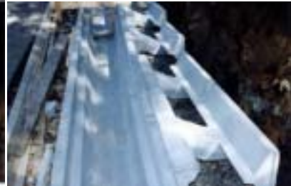
据付完了状況
