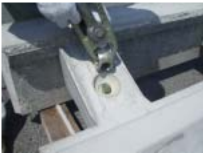
F型基礎ブロック吊状況 (1m製品)
