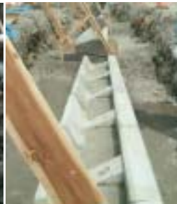
打設完了状況
