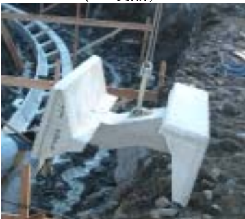
F型基礎ブロック吊状況 (1m製品)
