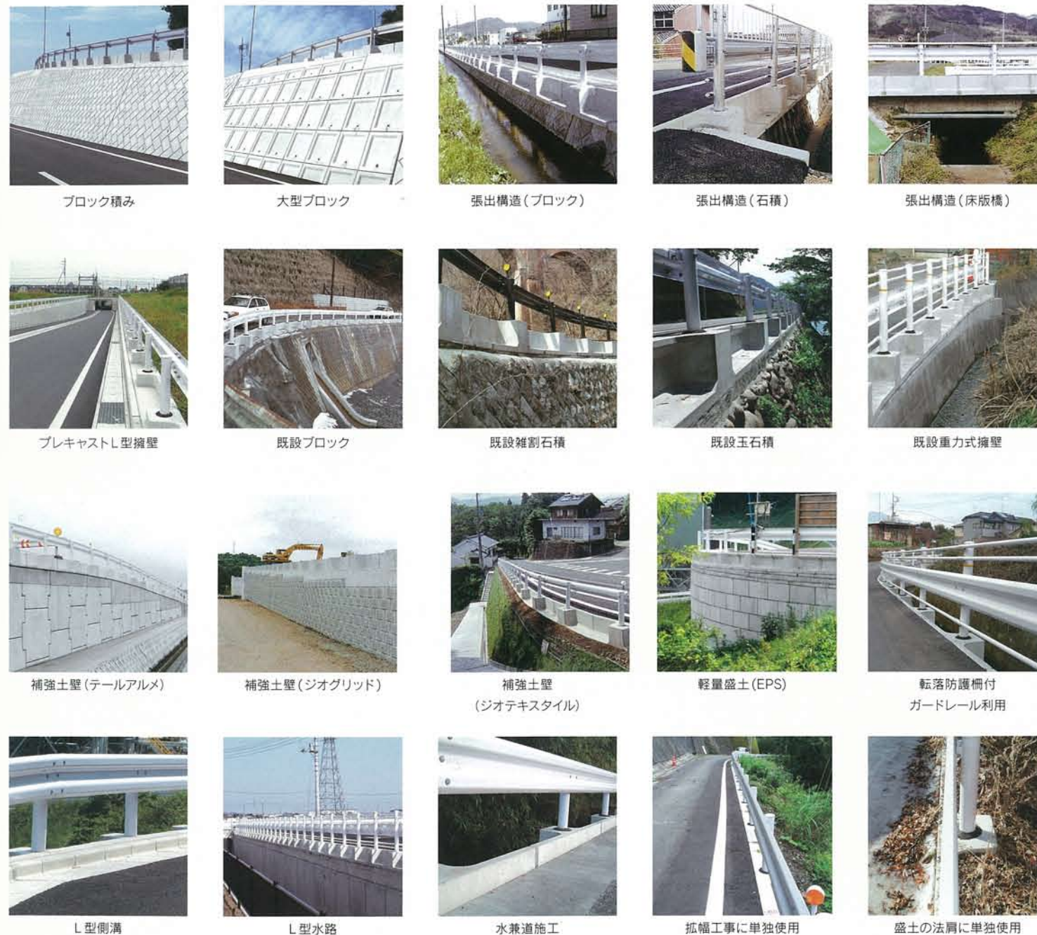
L型側溝 L型水路 水兼道施工 孤幅工事に単独使用 盛土の法肩に単独使用
