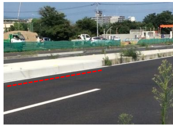
完了日：平成27年09月 前橋市 倉海土地地区整理事業
