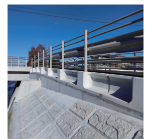
L型擁壁天端上
