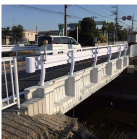
橋梁改修(張出し)
