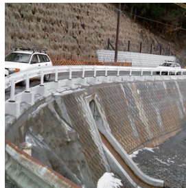
既設ブロック
