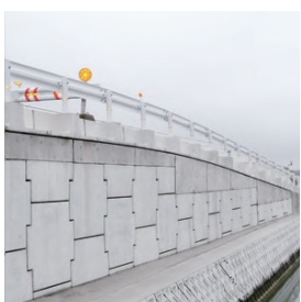
補強土壁(テールアルメ)
