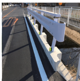
橋梁改修(張出し)
